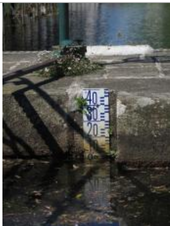
Echelle amont de l'écluse de Lestitut
