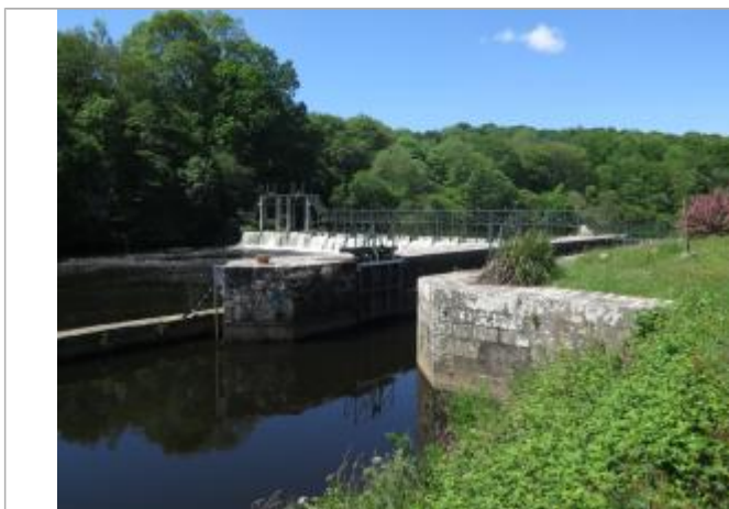
aval écluse de Divit (échelle disparue)
