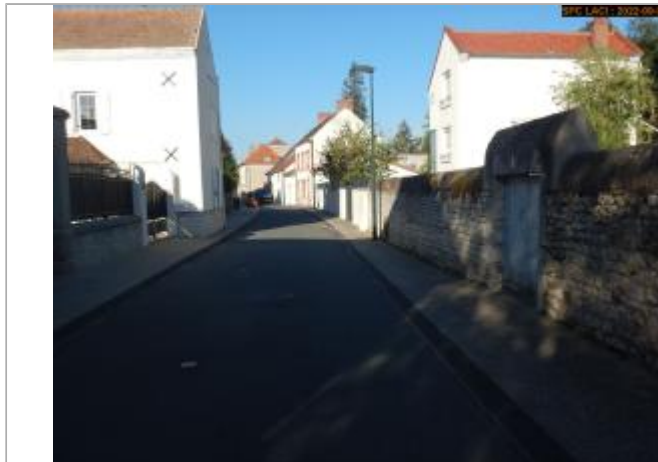
Vue du site éloignée
